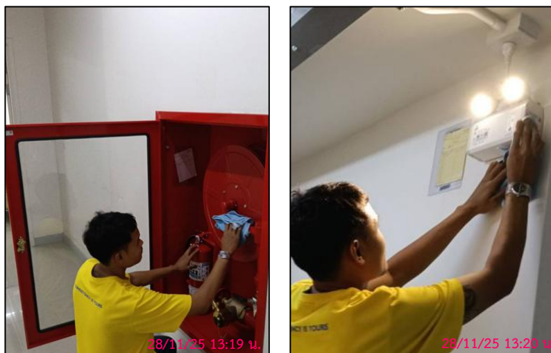
รูปภาพที่ 2.32 การตรวจสอบระบบป้องกันอัคคีภัย
