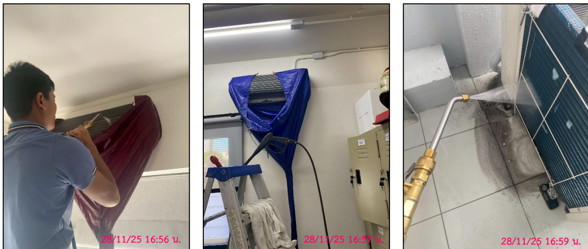
รูปภาพที่ 2.36 การล้างเครื่องปรับอากาศ
